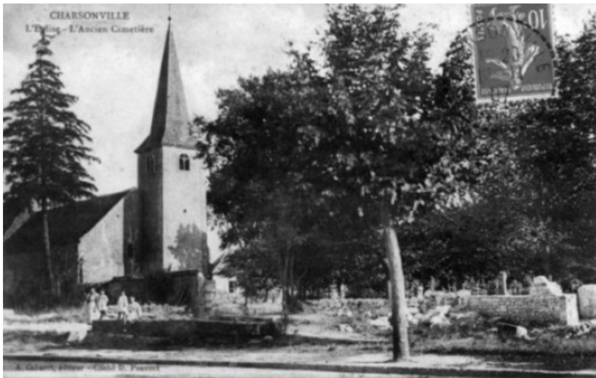
L'élargissement de la route côté place a été réalisé Le presbytère est démoli et son jardin a disparu On aperçoit encore des croix dans l'ancien cimetière
