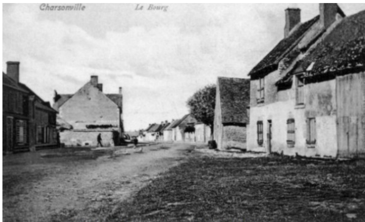
Les habitations existent toujours en extrémité de la place Maison abandonnée de Champenois à droite
