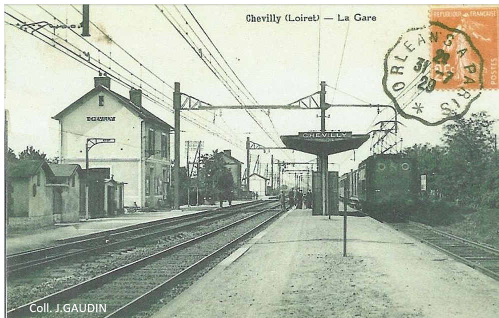
A partir de 1926 : électrification de la ligne Paris-Vierzon
