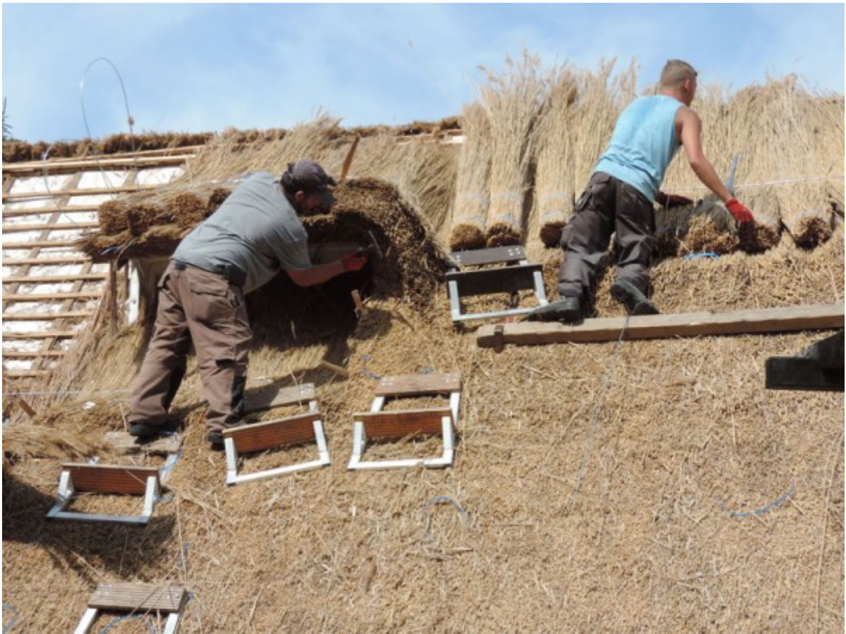
Le toit est progressivement couvert
