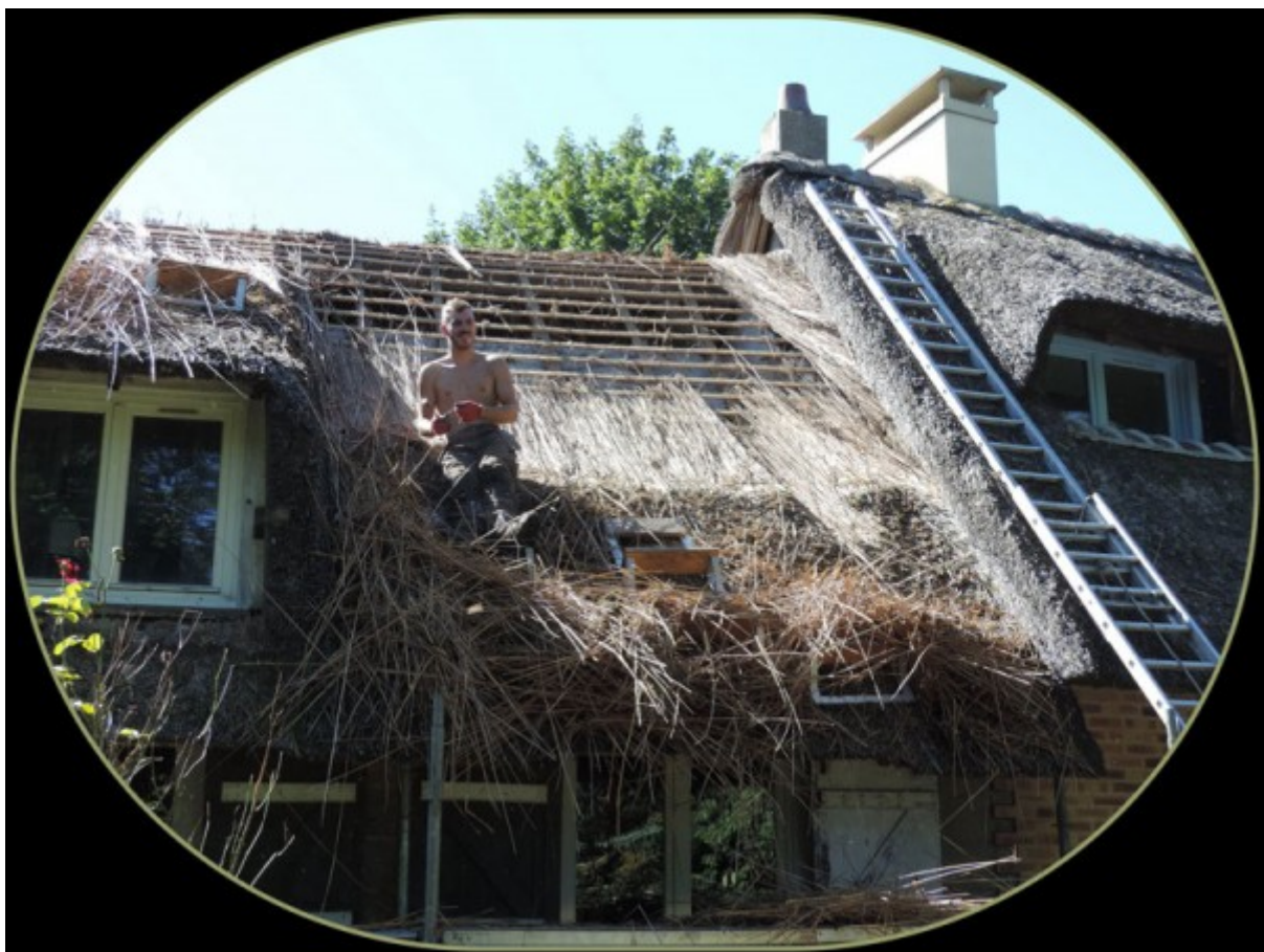
l'enlèvement d'une couverture 'usée'
