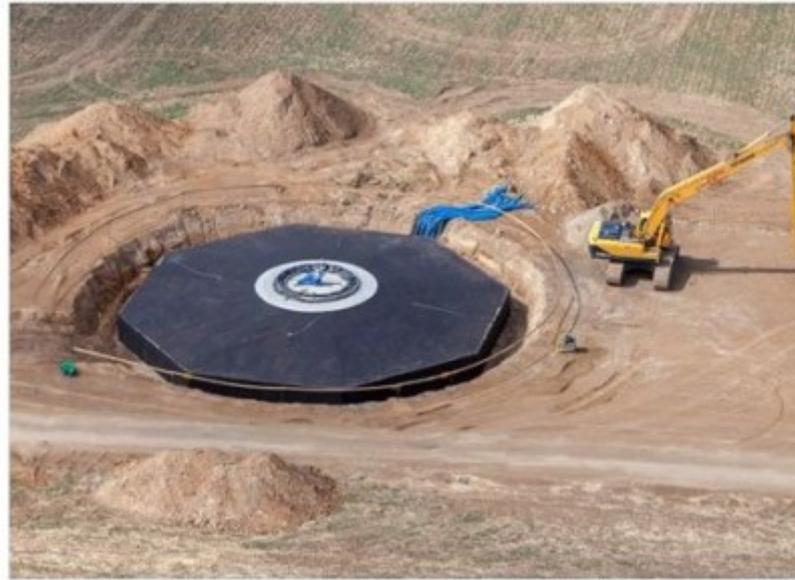
***Le socle en béton armé avec au centre , l'emplacement du fuitur mat et la pose des gaines (bleus) pour la connexion au réseau électrique***
