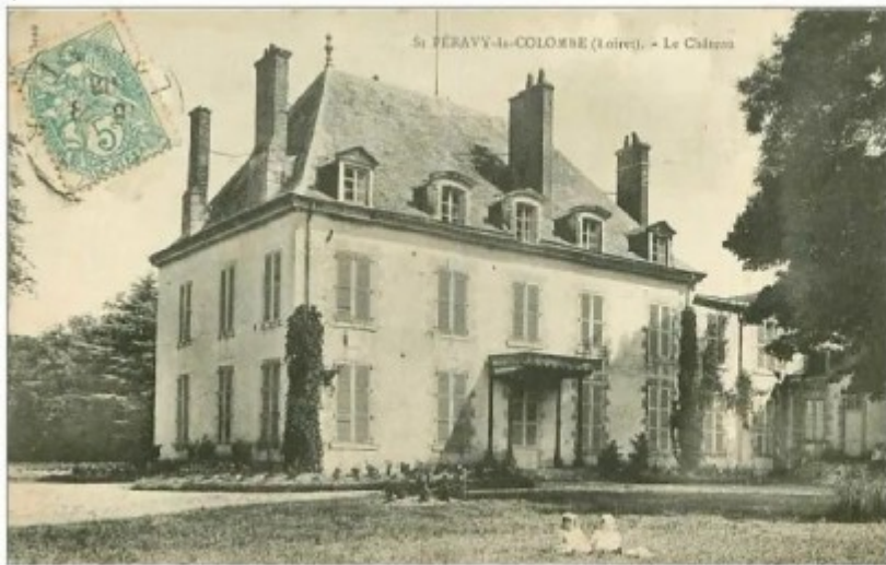
Château de la Fontaine Saint Pérayy la Colombe
